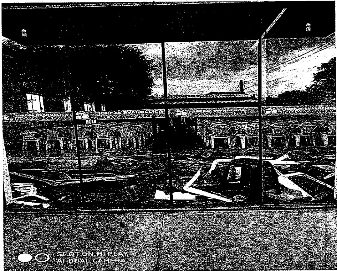
Imagens da Igreja Evangelica Nova Canaã, queda do platibanda e telhado.
